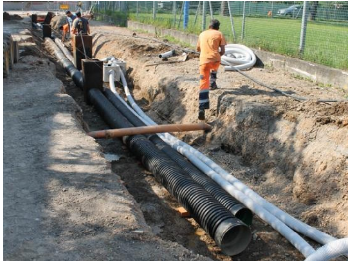
Fig.2.23 ESEMPIO DI INTERVENTO IN POLIFORA O CAVIDOTTO
