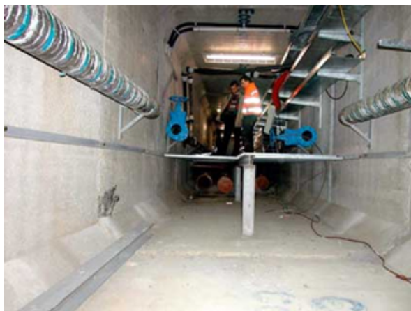
Fig.2.25 ESEMPIO DI INTERVENTO IN GALLERIE PLUTISERVIZIO
